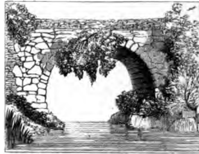
BRIDGE OF XEROKAMPO.
